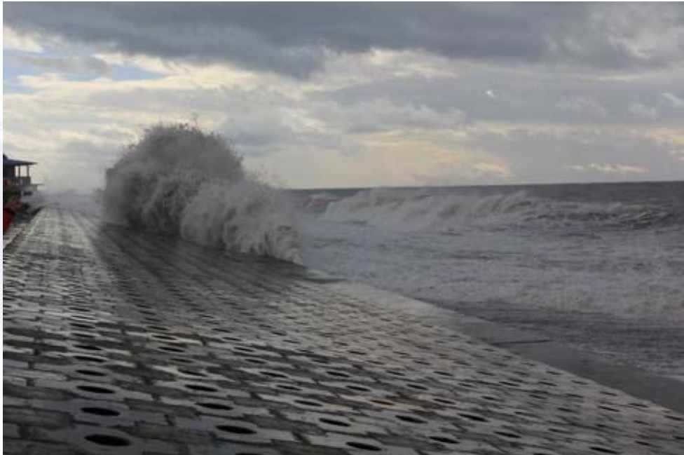
Рис.3. Жесткое воздействие поверхностных волн на защитное сооружение [ЦНИИС]
