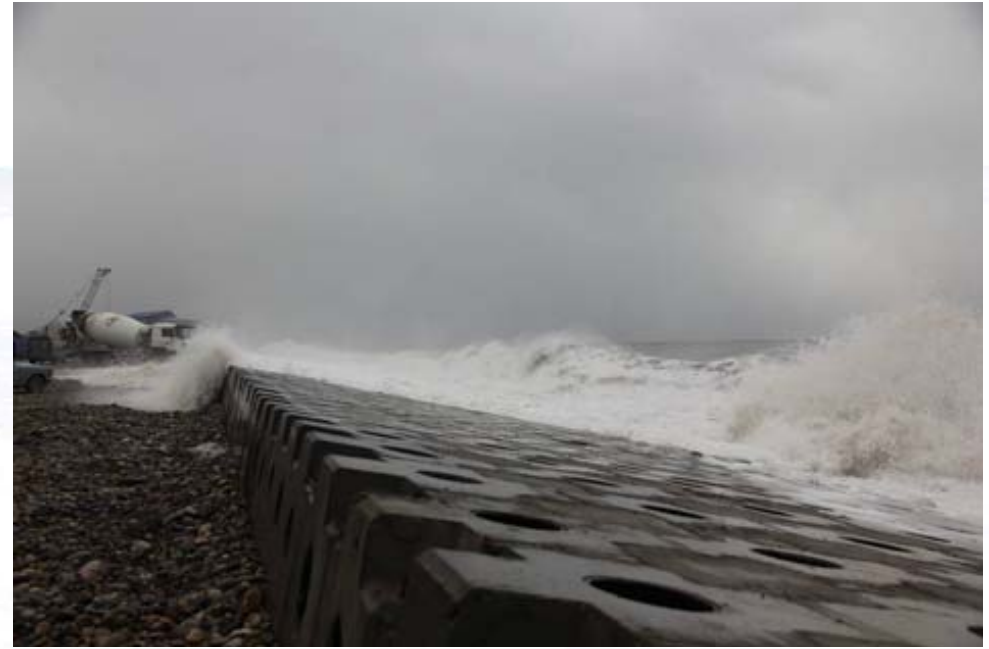
Рис.3. Жесткое воздействие поверхностных волн на защитное сооружение [ЦНИИС]
