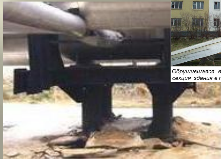
Деформация опор трубопровода Провал дороги
